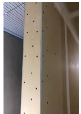
100～150mmピッチ 左右少しずらして固定
